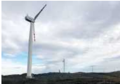
設置した風力発電機の様子
