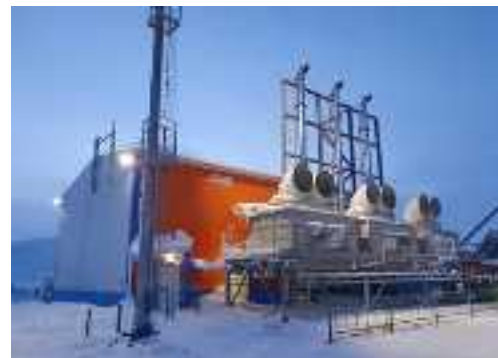
建設した発電所建屋の外観
