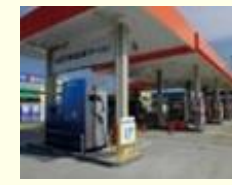
水素 ステーション
