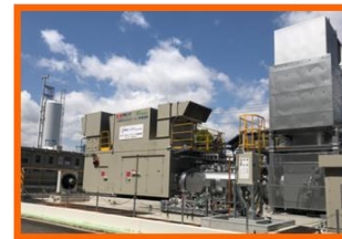
水素CGS エネルギーセンター
