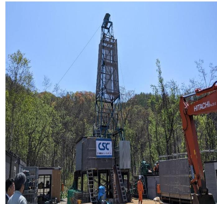
CO<sub>2</sub>地下固定実験現場でのボーリング作業
