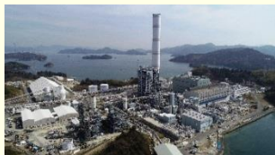
高効率火力発電所
