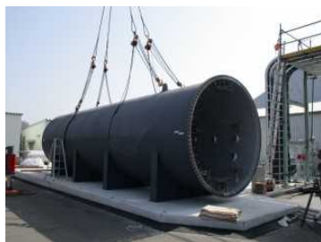
圧力容器搬入
