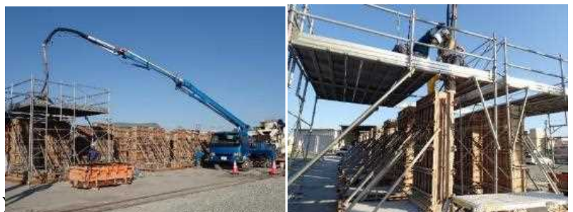
図2 石炭ガス化スラグ細骨材を使ったコンクリートの壁を模擬した試験体の施工状況
