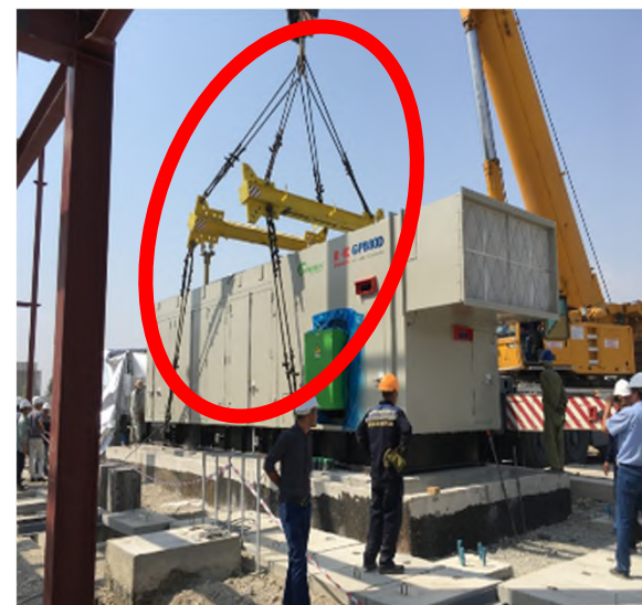
250tクレーンによる7MWガスタービン吊り上げの様子
