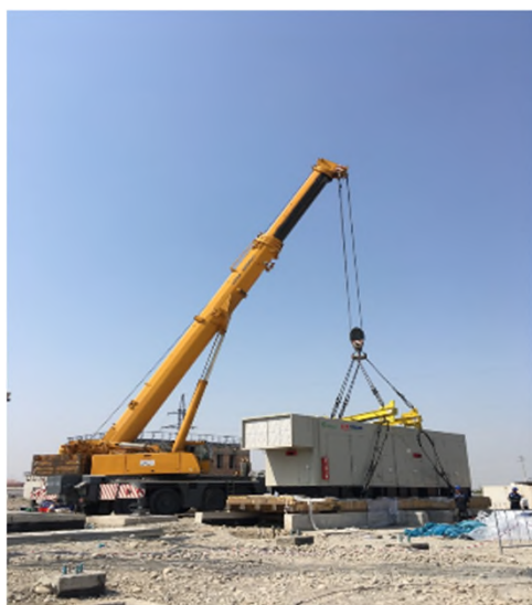
250tクレーンによる7MWガスタービン吊り上げの様子
