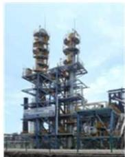
CO<sub>2</sub>と液体との化学反応を利用して分離・回収する方法
