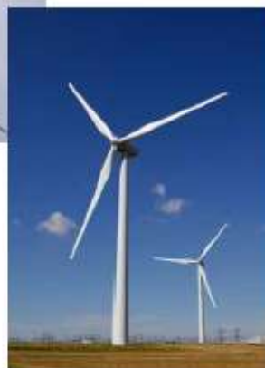
発電・コジェネシステム
