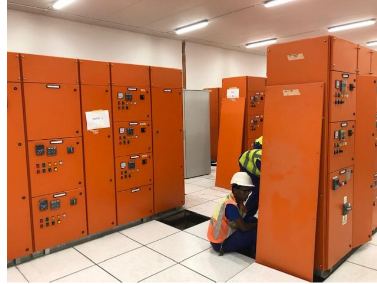
電気盤工事中
