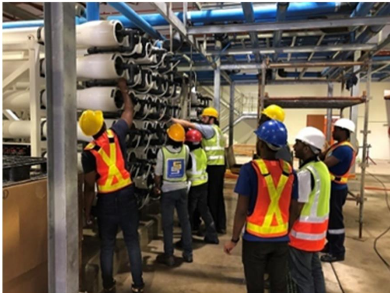
膜ユニット据付作業
