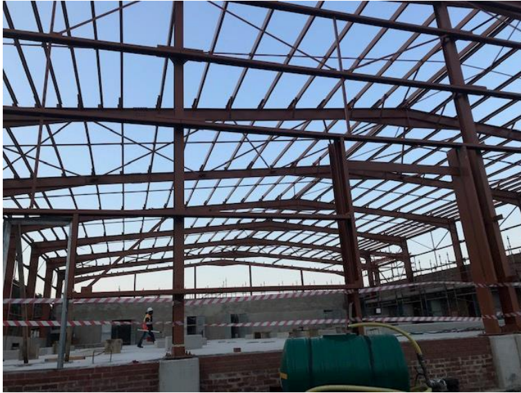
鉄骨建屋建設中
