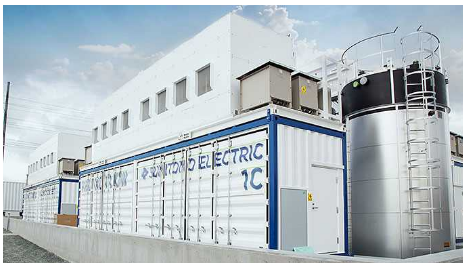
米国加州サンディエゴに設置したレドックスフロー蓄電池
