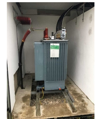
OLTC付中圧/低圧変圧器
