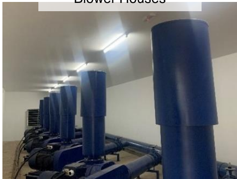
ブロワ設置建屋の建設 Blower Houses
