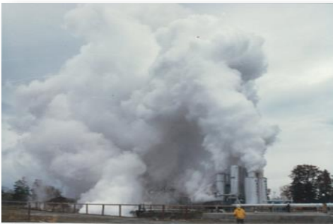
【地熱探査技術等検証調査】 秋田県澄川地域N61-SN-7D (3,000m)での長期噴気試験にて 蒸気流量194t/hを記録。 出典：三菱マテリアル(株)
