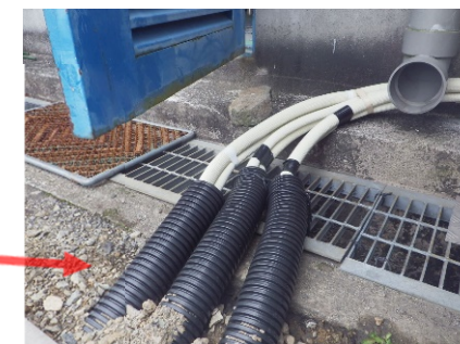
〔FEP管布設状況〕
