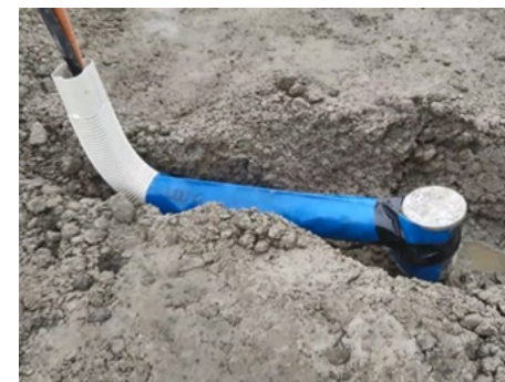
熱交換器養生
