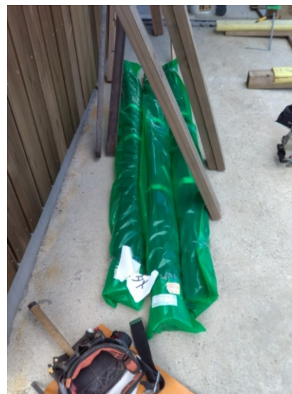
プレカット配管
