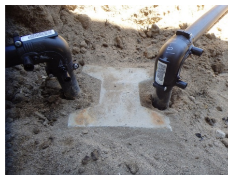
電気融着後の配管とPC杭
