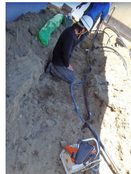
配管の電気融着
