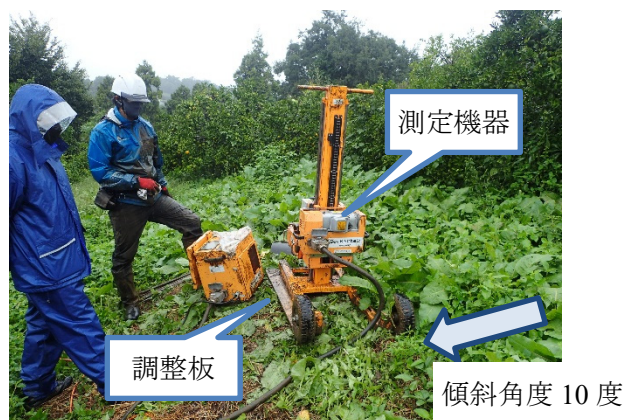
図 2-9 傾斜地の地盤調査風景
