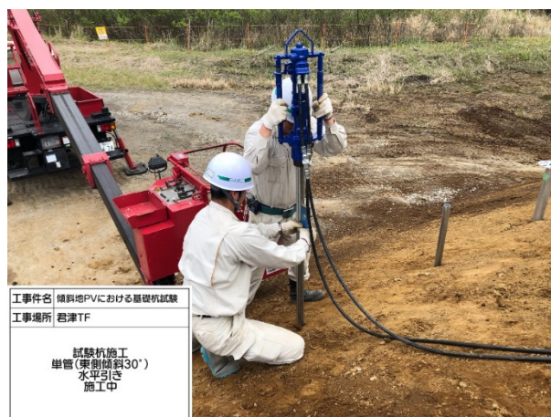
図 4-4 傾斜角度 30 度 足場不安定（傾斜地）からのハンド工具による施工風景（単管）
