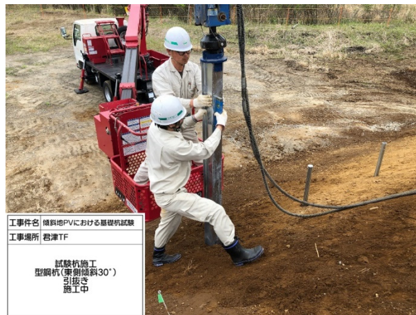
図 4-3 傾斜角度 30 度 足場安定（高所作業車）からの重機による施工風景（形鋼杭）
