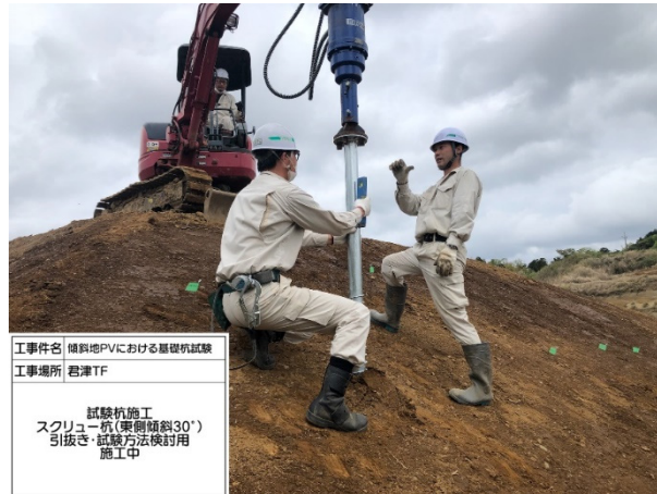
図 4-2 傾斜角度 30 度 平地（法肩）からの重機による施工風景（スクリュー杭）
