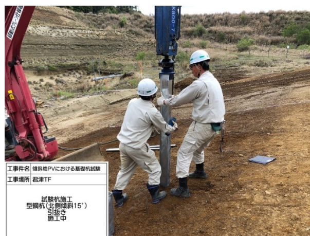
図 4-1 傾斜角度 15 度重機による施工風景（形鋼杭）
