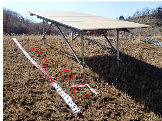
図 5-2 15 度植生工 架台（長辺傾き 3 度）
