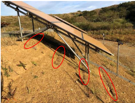
図 5-5 30 度裸地 架台（長辺傾き 3 度）
