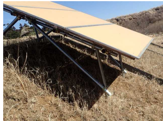
図 5-6 30 度植生工 架台（長辺傾き 3 度）
