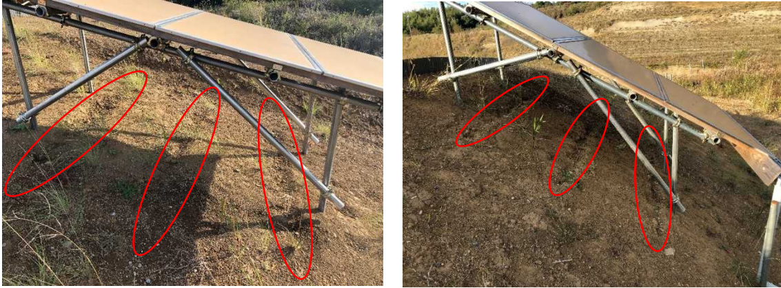
図 5-9 水路付き架台（左：15 度傾斜、右：30 度傾斜）
