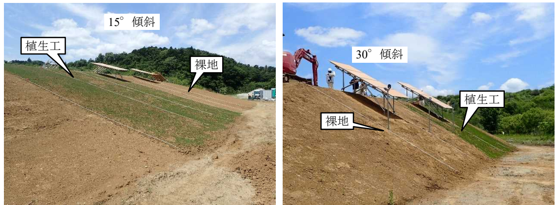
図 4-2 検証対象の傾斜地状況
