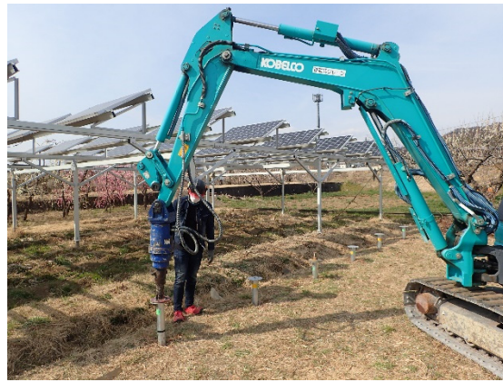
図 4-1 農地での杭の打設風景
