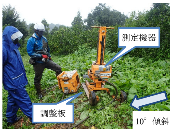
図 2-1 農地（傾斜）の地盤調査風景
