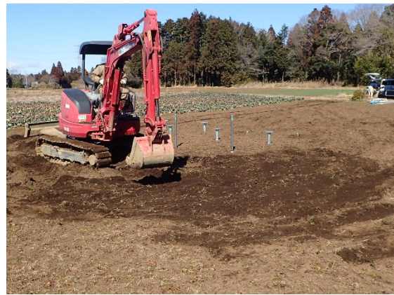
図 4-2 農地での杭の打設後の表土風景（左：打設後、右：整地後）
