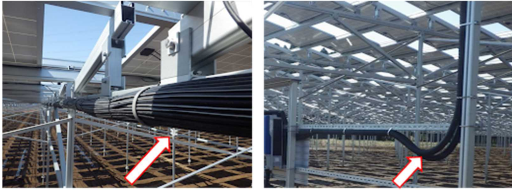
ケーブル敷設
