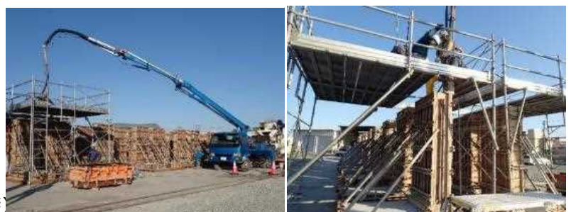
図2 石炭ガス化スラグ細骨材を使ったコンクリートの壁を模擬した試験体の施工状況
