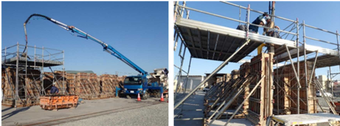
図 7 石炭ガス化スラグ細骨材を使ったコンクリートの壁を模擬した試験体の施工状況
