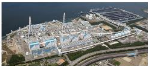
碧南火力発電所（9号機が完成）
