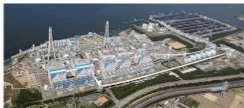
碧南火力発電所（愛知県豊田市）
