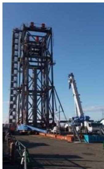
ジャッキアップ前
