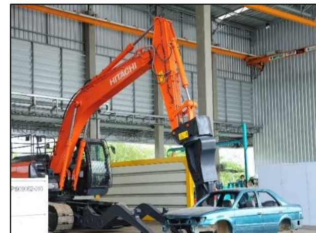
導入技術(解体用重機)
