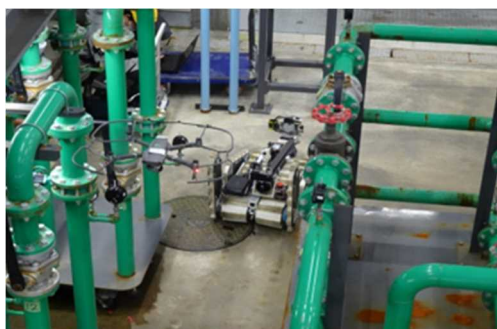
写真1 ドローンとの連携による点検
