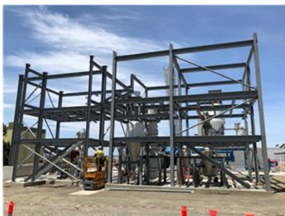
図 46 小型ガス化試験設備 建設状況（2020年1月）
