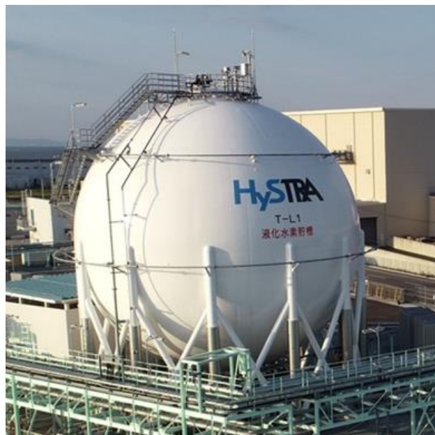
図 33 貯蔵タンク全景（設置完了後）
