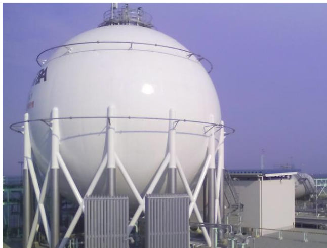
図 36 貯蔵タンク周辺
