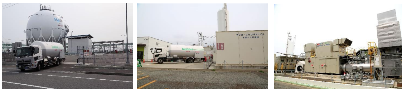
図 49 神戸 CGS への液化水素供給の様子
