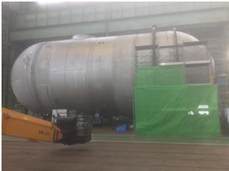
図 11 内槽製作状況
