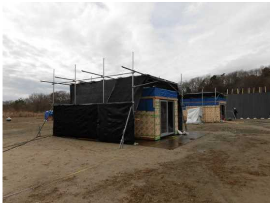
鉾山堆積場跡地に設置した鋼製模擬室
