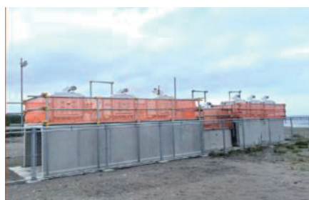
▲ドップラーライダー設置用架台
