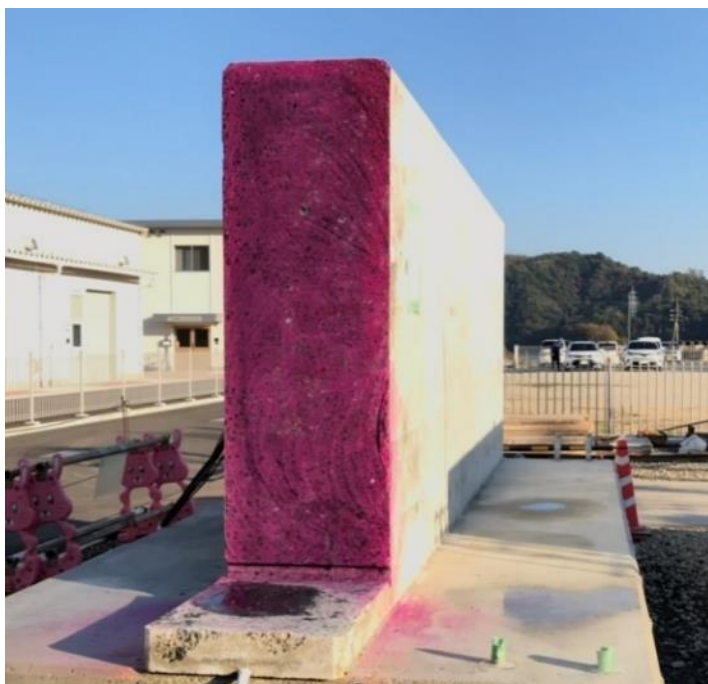
試験体の切断面 (フェノールフタレイン1%溶液噴霧後)
