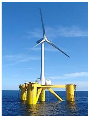
経済産業省 福島沖 2.0~7.0MW 2020fy実証終了・撤去済み
