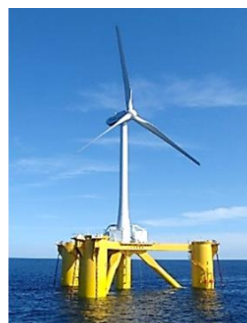
経済産業省 福島沖 2.0~7.0MW 2020fy実証終了・撤去済み
