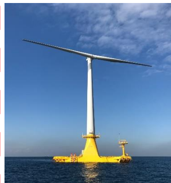
NEDO北九州沖 3.0MW 実証研究中
