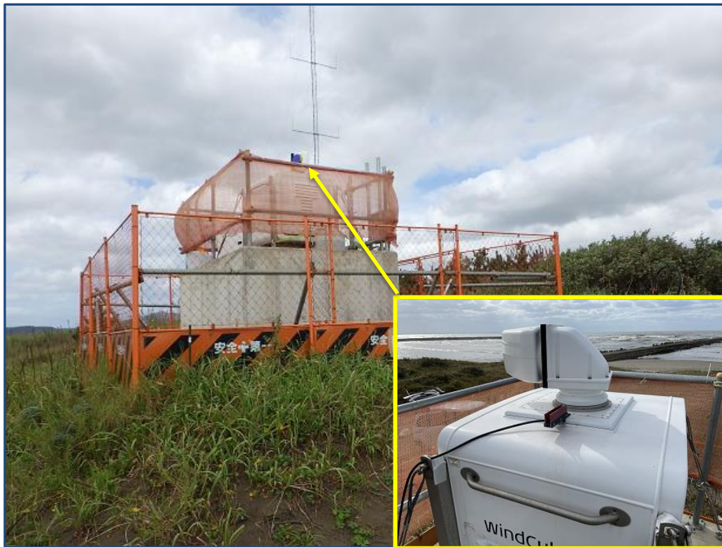
図 スキャニングライダーおよび鉛直ライダーの設置状況
