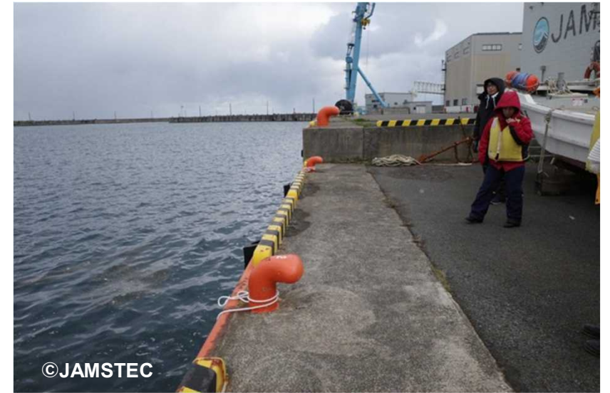
むつ研での設置作業
