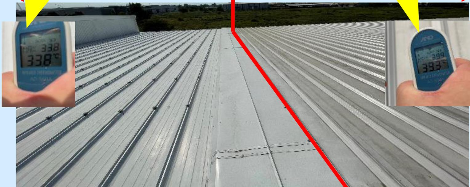
施工後7か月で表面汚れの差によって表面温度にも大きな差が発生
