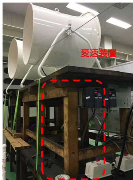
図 2. 1. 1. 7-143 送風機と変速装置
