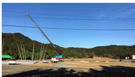
図 2.1.1.7-197 ホーペック鳥羽工場 敷地内
