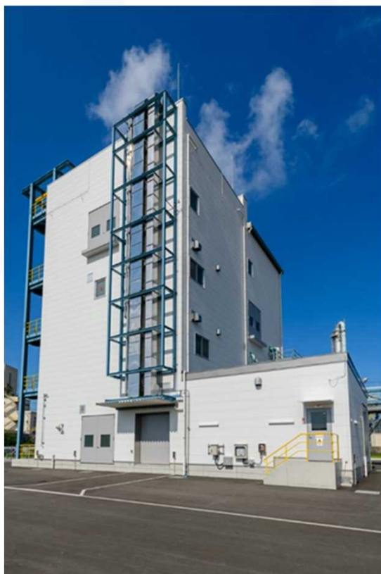
新規建設開発棟
