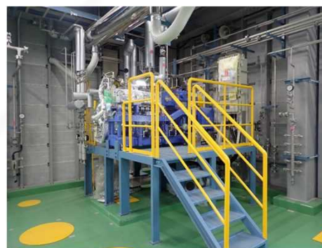
紡糸開発設備
