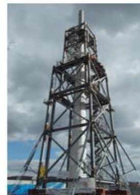
タワージャッキダウン 解体工法
