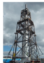
タワージャッキダウン 解体工法
