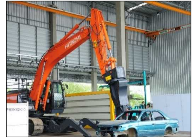
導入技術(解体用重機)
