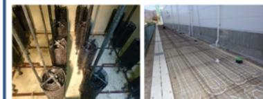
排水浄化槽の熱回収による融雪
