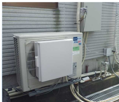
直接膨張方式地中熱ヒートポンプ
