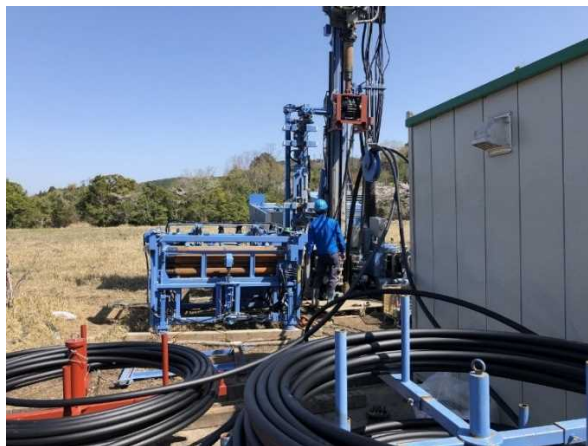
ロッドチェンジャーおよびロッドストッカー(左)、 地中熱交換器挿入機を用いた地中熱交換器挿入の様子(右)
