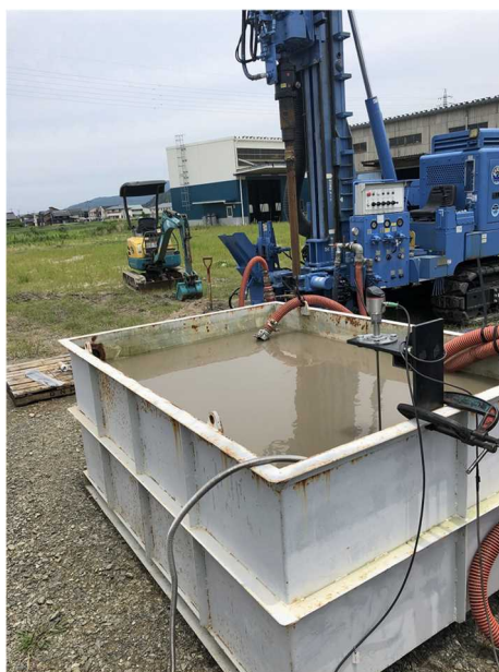
掘削機を設置した状態での TRT
