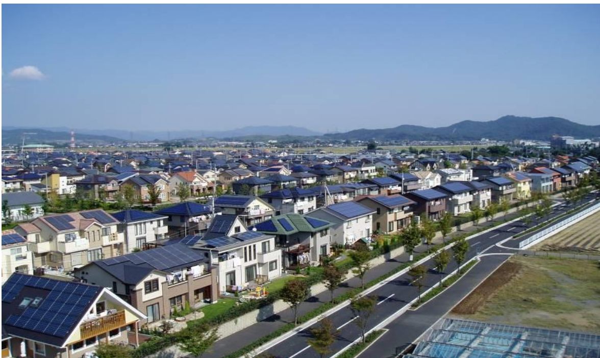
戸建て住宅群に於ける太陽光発電の例 合計 2,130kW、553戸 (1戸平均3.85kW) (群馬県太田市) 提供: 太田市土地開発公社
