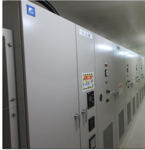
受配電設備 (40ftコンテナ内収容)
