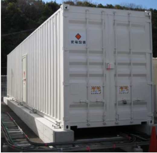
受配電設備 (40ftコンテナ内収容)
