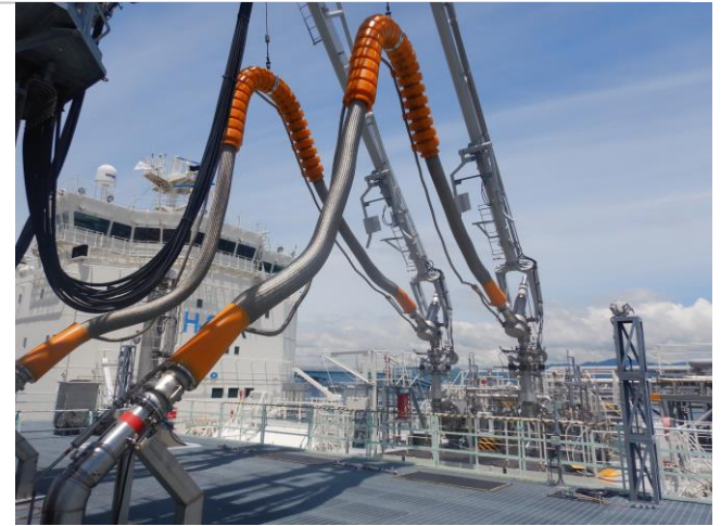
荷役試験実施中の状況
