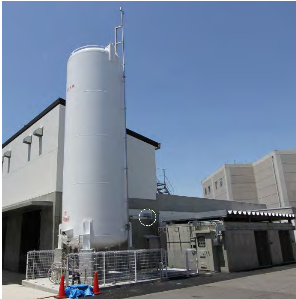
液化水素貯槽 2024年3月竣工
