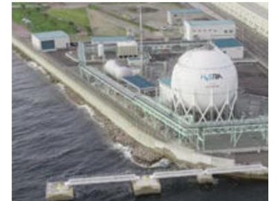
国内最大の液化水素貯槽 2,500m 3 の球形貯槽
