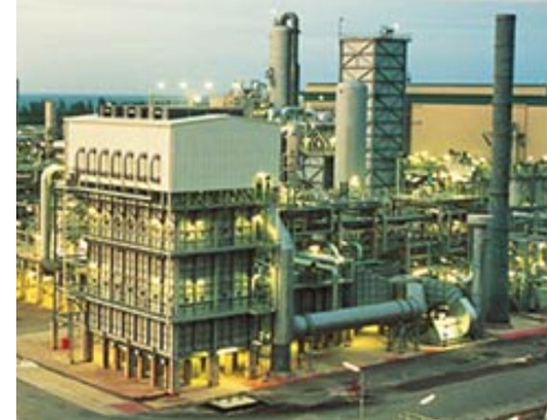
日揮が納入した天然ガス水蒸気改質炉(SMR)外観
