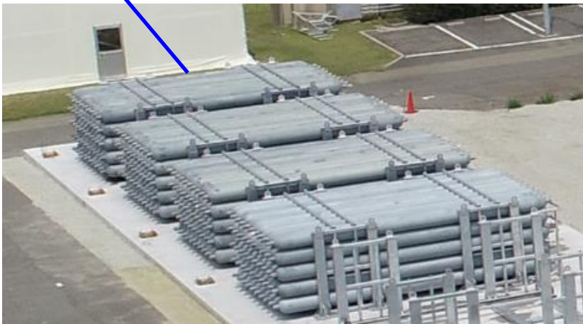
全7基中、4基を据付時点の写真
