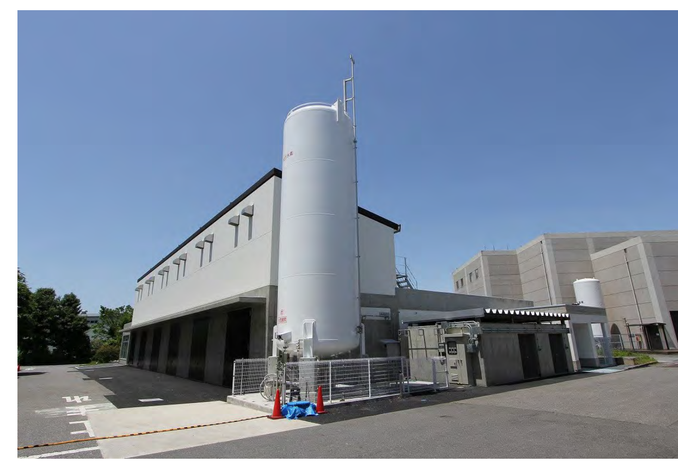
特殊実験施設（液化水素貯槽）
